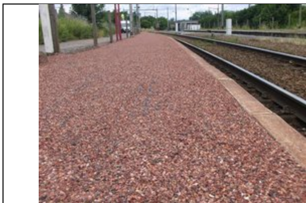
Revêtement du quai
