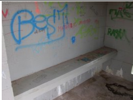
Banc dans l'abri
